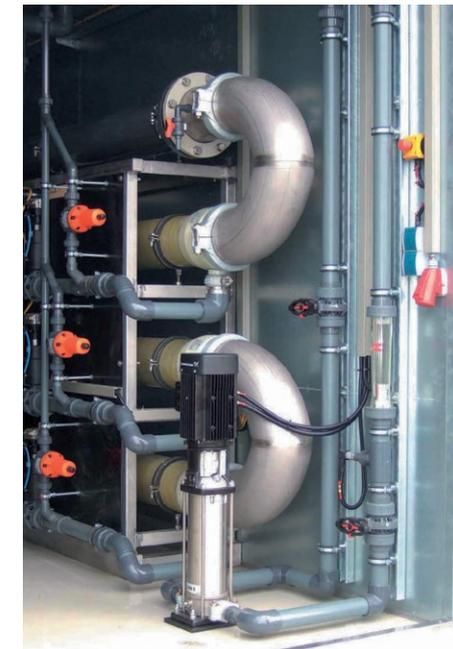
Abb. 6: Industrieanlage mit geregelter Pumpe
